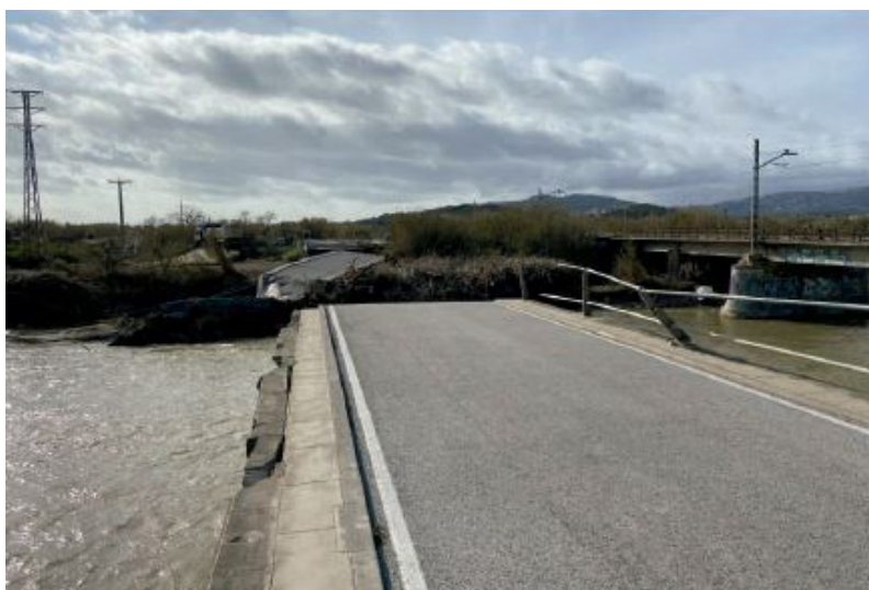
TRENCAMENT DEL PONT DE LA BV-6002
